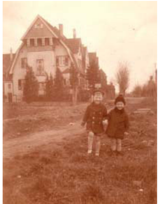
Abb. 6 Goethestraße, von Süden - (datiert April 1928) - Quelle: Nachlass Architekt H. Troost, Brühl
