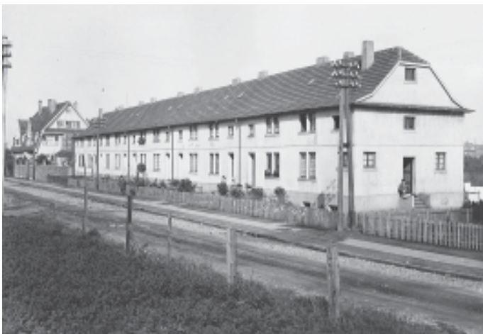
Abb. 3 Römerstrasse im Bau (um 1929) Die Aufnahme entstand während der Asphaltierung der heutigen Römerstrasse. Sie zeigt hinter der Zeile der Bergarbeiterhäuser das (vorspringende) im Zweiten Weltkrieg völlig zerstörte Doppelhaus Clemens-August-/Römerstrasse - Quelle: Hist. Archiv der Stadt Brühl
