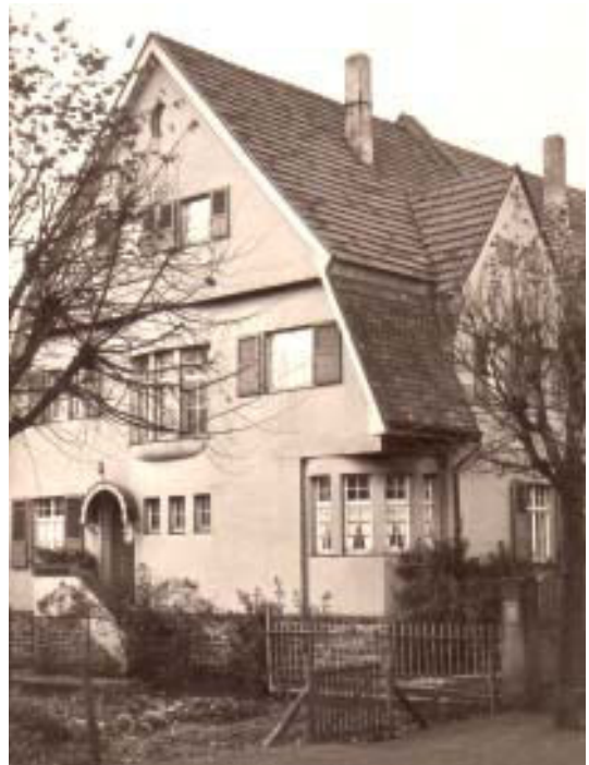
Abb. 4 Clemens-August-Strasse 54 - undatiert (um 1925/30) Quelle: Nachlass Architekt H. Troost, Brühl
